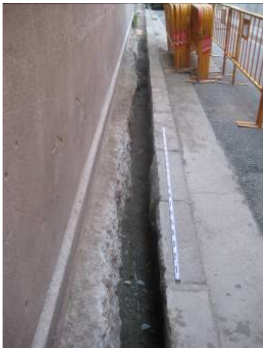
Fotografia 1. Detall de la rasa oberta al Passatge Gutenberg, 2-6.
