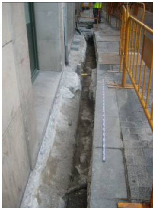
Fotografia 6. Detall dels murs UU.EE. 23 i 24.
