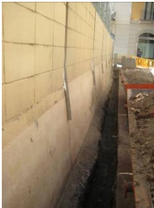
Fotografia 2. Detall de la rasa oberta al Passatge Gutenberg, 2-6.
