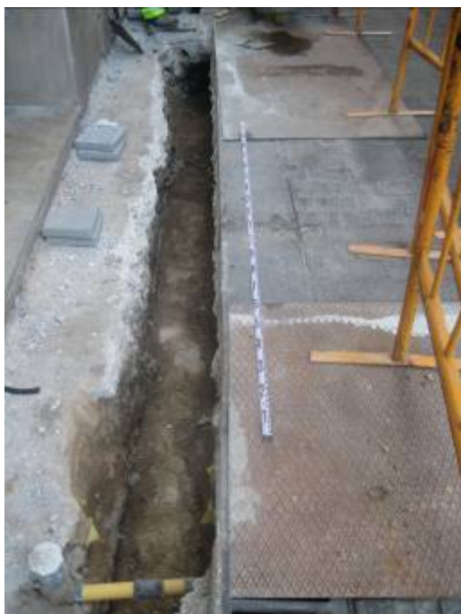
Fotografia 5. Detall del mur U.E.24.
